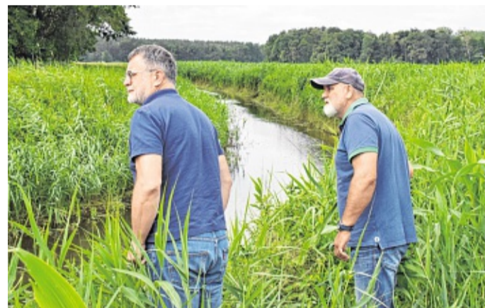
Eine besonders problematische Böschung: Andreas Schwebs (l.) und Thomas Wojak begutachten den Bresegarder Mühlenbach.
