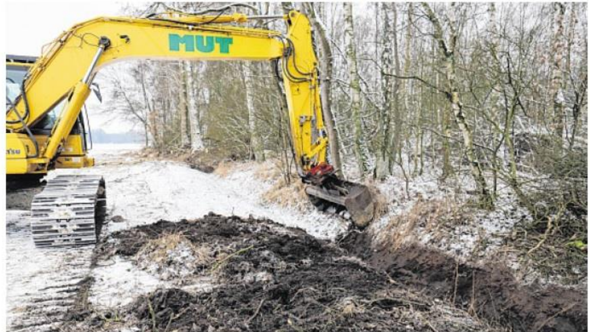
Ein kleiner Graben nahe Steegen wurde in diesen Tagen wieder hergerichtet.
