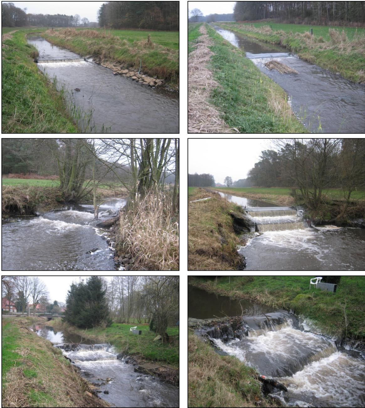
*Abbildung 3: Sohlenabstürze im Strohkirchener Bach (M1.1 links oben, M1.2 rechts oben, M5 links Mitte, M6 rechts Mitte, M7 unten)*
