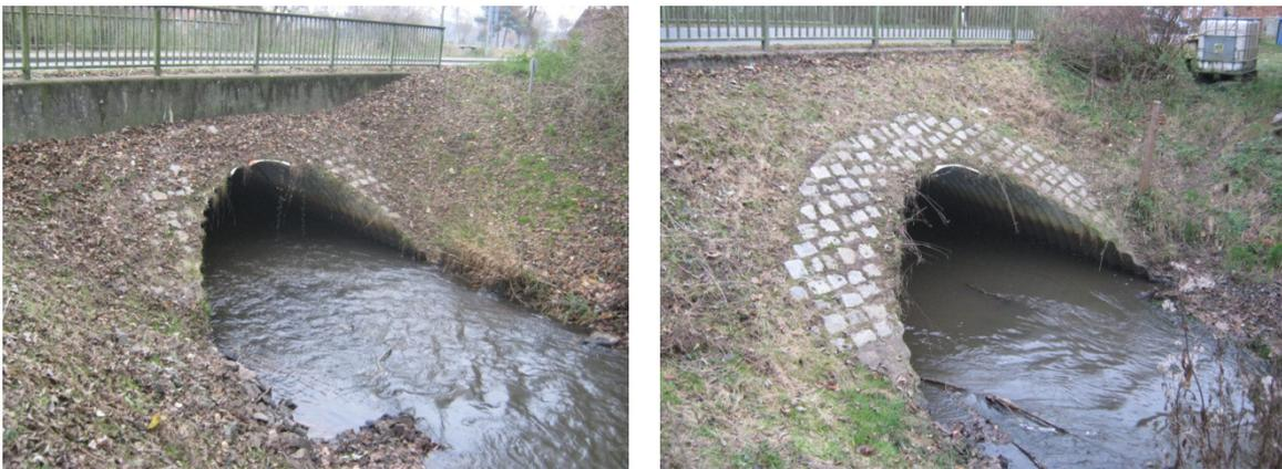
Abbildung 6: HAMCO-Durchlass in Strohkirchen (links: Einlauf, rechts: Auslauf)
