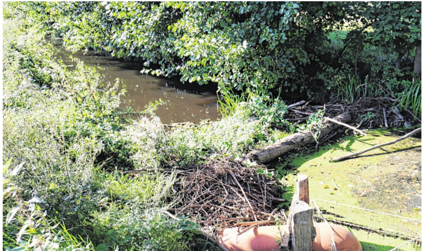
Biberdamm im Boizenburger Gammgraben: Von hier sind es nun wenige Meter bis zum Auslauf des Klärwerkes. Im Vordergrund das rötliche Rohr des so genannten Bibertäuschers. Der kann das Wasser nicht mehr absenken, weil es einen zweiten Damm gibt. FOTO: POHLE
