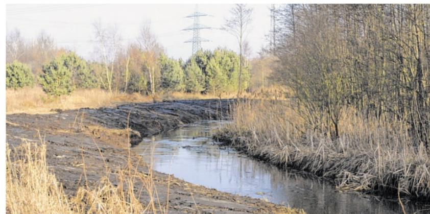
**Nach der Sanierung** des Flussbettes hat sich die Fließgeschwindigkeit der Boize erhöht. Der Bewuchs an der rechten Uferseite wurde nicht zurückgeschnitten.
