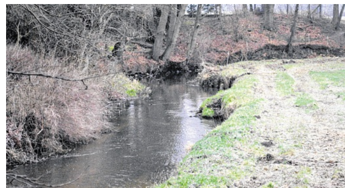
Die Motel mäandert, Uferbereiche sind ausgespült.
